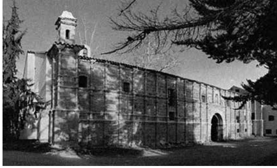
Fachada del Monasterio de Piedra, marzo 2018. Fot. autora.
