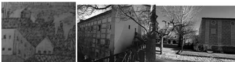
Izquierda: Detalle del dibujo publicado en 1842 con el posible edificio de la enfermería. Derecha: Monasterio de Piedra, marzo 2018. Fot. autora.
